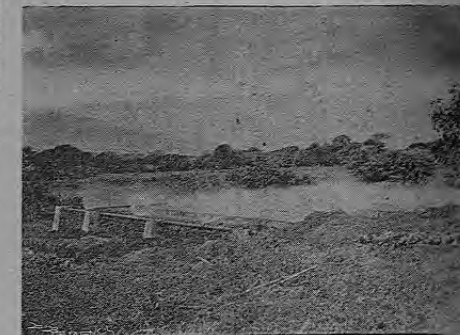
Filtros de piedra quebrada y arena de la planta de purificación de las cloacas.
