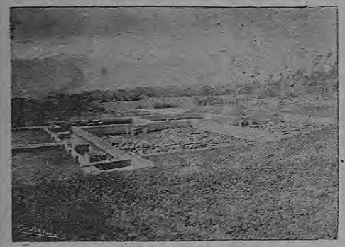
Hechos de contacto de la planta de purificación de las cloacas.
